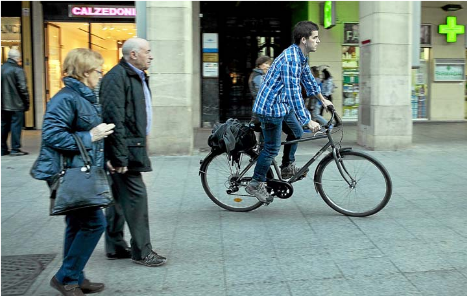
Las aceras del paseo de la Independencia, con la calzada cortada por las obras del tranvía, son de las más transitadas por los ciclistas. ARÁNZAZU NAVARRO
